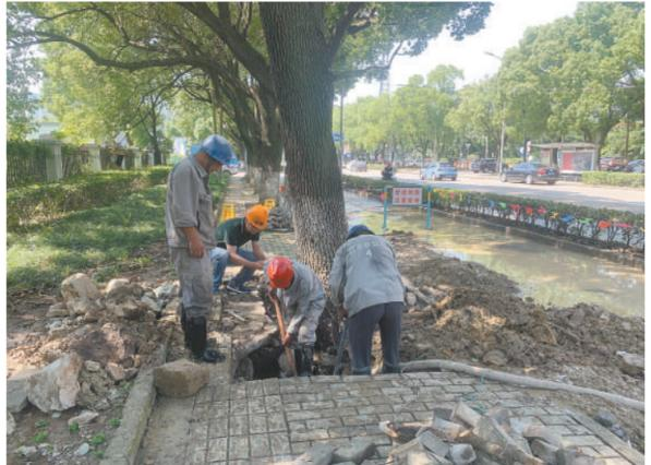
6月23日，玉立路发生DN400自来水管爆裂，市自来水公司抢修队闻讯后即刻赶赴现场，组织抢修，至当天18时成功修复漏点，并完成管网冲洗，恢复附近用户的正常生产生活用水。
